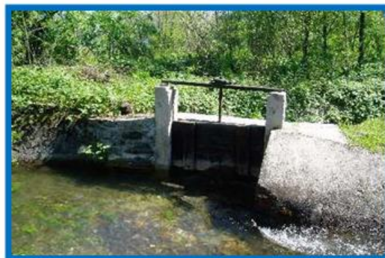
Figura 7: canale Secondario Villorresi
