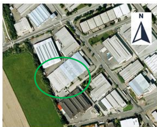
Figura 17: localizzazione capannone TAO AMBIENTE
